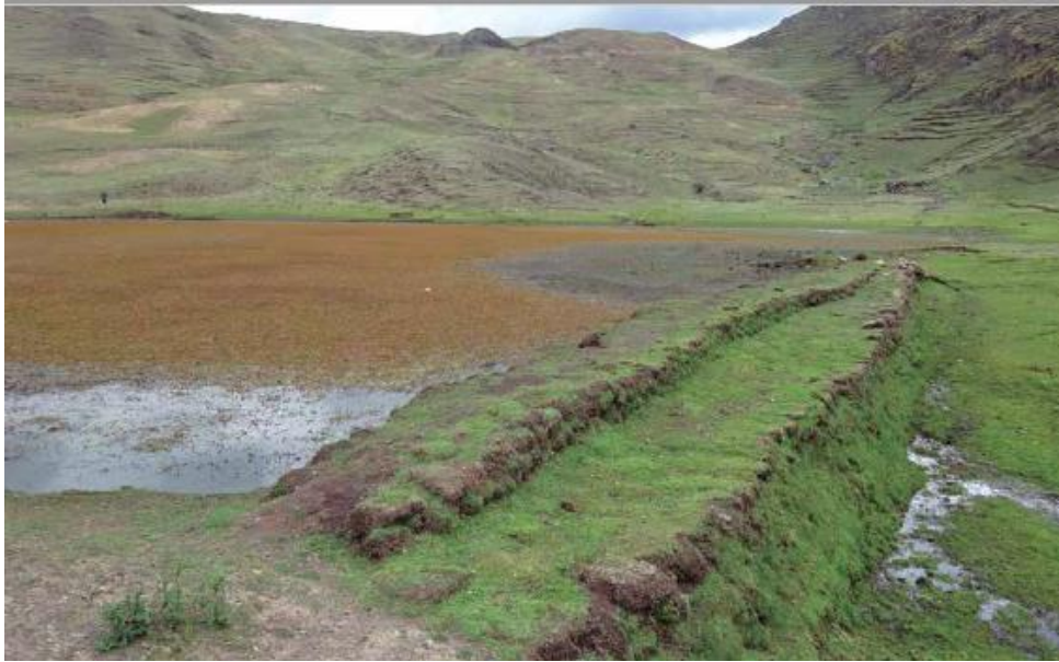
Retención de agua en una q'ocha para favorecer la humedad del subsuelo en zonas alledañas. Se ha construido un dique sencillo de champas (terrones) con la finalidad de infiltrar el agua desde el fondo hacia zonas alledañas para el mejoramiento de la cobertura vegetal. Microcuenca Chuecamayo, San Salvador, Calca, Perú. Jan Hendriks
