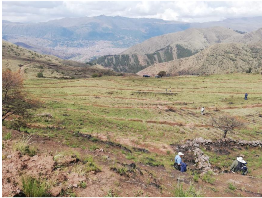
Figura 4. Zanjas de infiltración realizadas por la Comunidad de Pillao Matao, en San Jerónimo, (Cusco, Perú) en colaboración con la ONG Guaman Poma de Ayala. Esta comunidad se abastece gracias a una galería drenante de 180 m de longitud situada aguas abajo (realizada por la citada ONG), en el sentido del flujo subterráneo, de las zanjas de infiltración.
