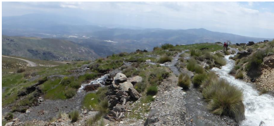
Figura 6. Acequia de careo vertiendo sus aguas en una ladera para su infiltración en la cuenca del río Mecina (Sierra Nevada, Granada, Sur de España).
